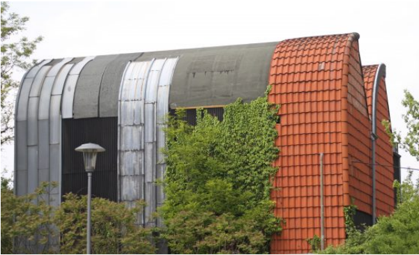
Südseite der Simultanhalle. Foto: Elke Wetzig / CC-BY-SA (via Wikimedia Commons)
